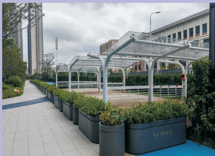
玻璃幕墙雨棚
